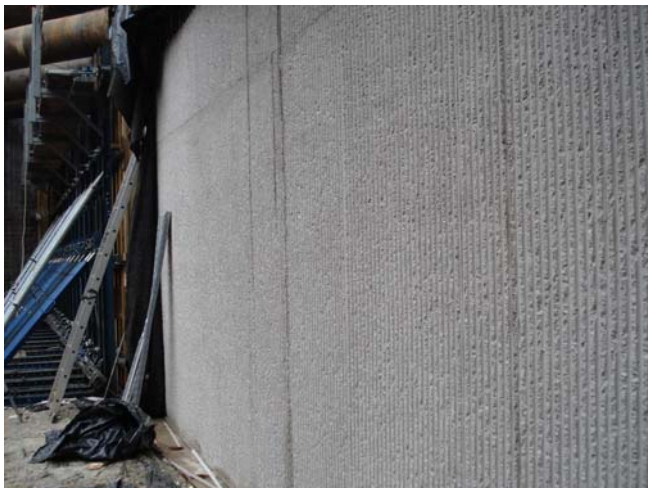
A Rákóczi téri metróállomás strukturált felülete. Építész: Dévényi Tamás
