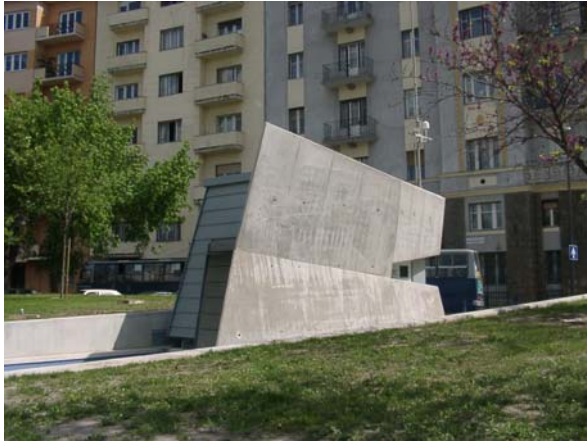
Levegőminőség-mérő állomás. Építész: Varga Péter István
