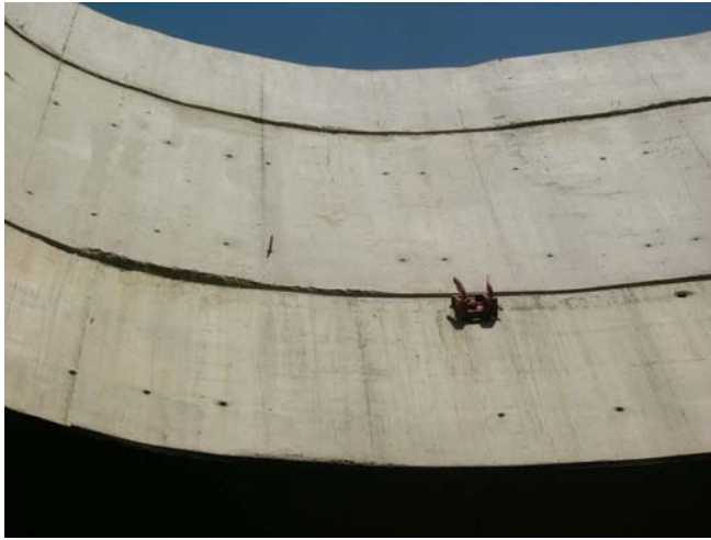
a Tétényi úti metróállomás „látszóbeton“ felülete
